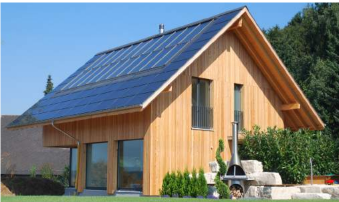
Sonnenhaus mit Solarthermie und Solarstrom
