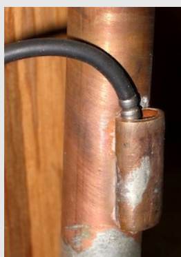
Doigt de gant confectionné avec un bout de DN 12 légèrement aplati et brasé sur une ligne.
