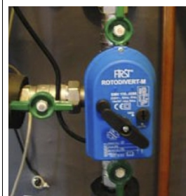
Une V3V ROTADIVER avec 3 vannes d'isolation
