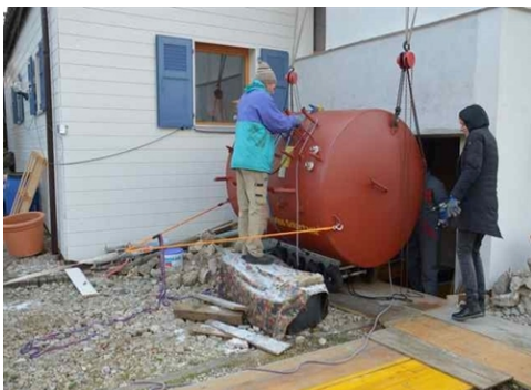
Un accu de 3500 L qui passera par l'ancienne porte de garage.
