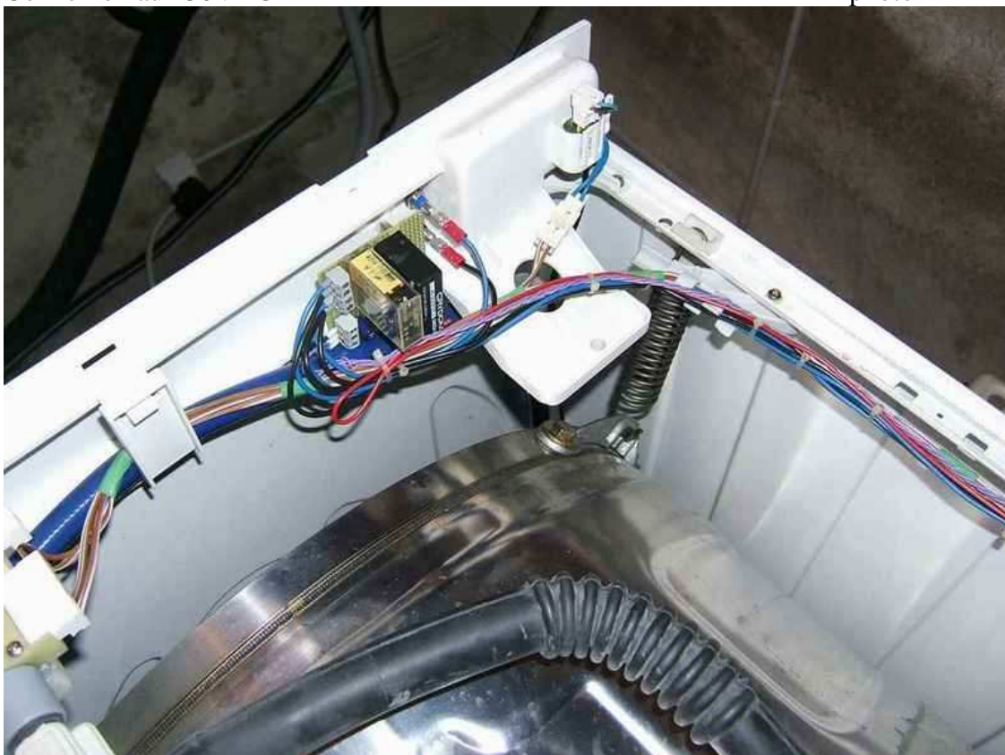
Le circuit rajouté et la prise pour l'électro-vanne montés à l'arrière
