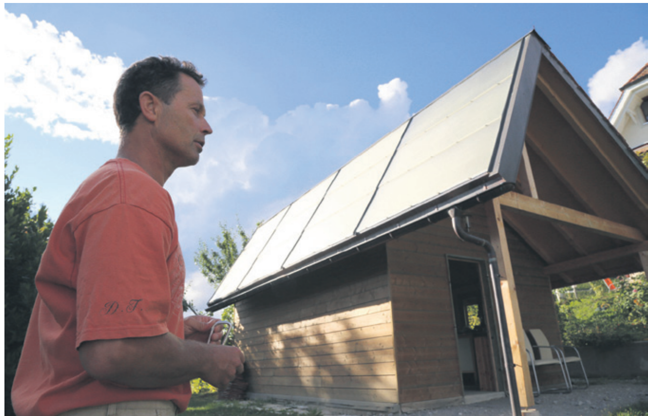
Avec l'installation de panneaux solaires thermiques sur son cabanon de jardin, Pierre Lavanchy chauffe sa maison familiale (des années 1930) à 80% au solaire et 20% au bois (deux stères par année).
