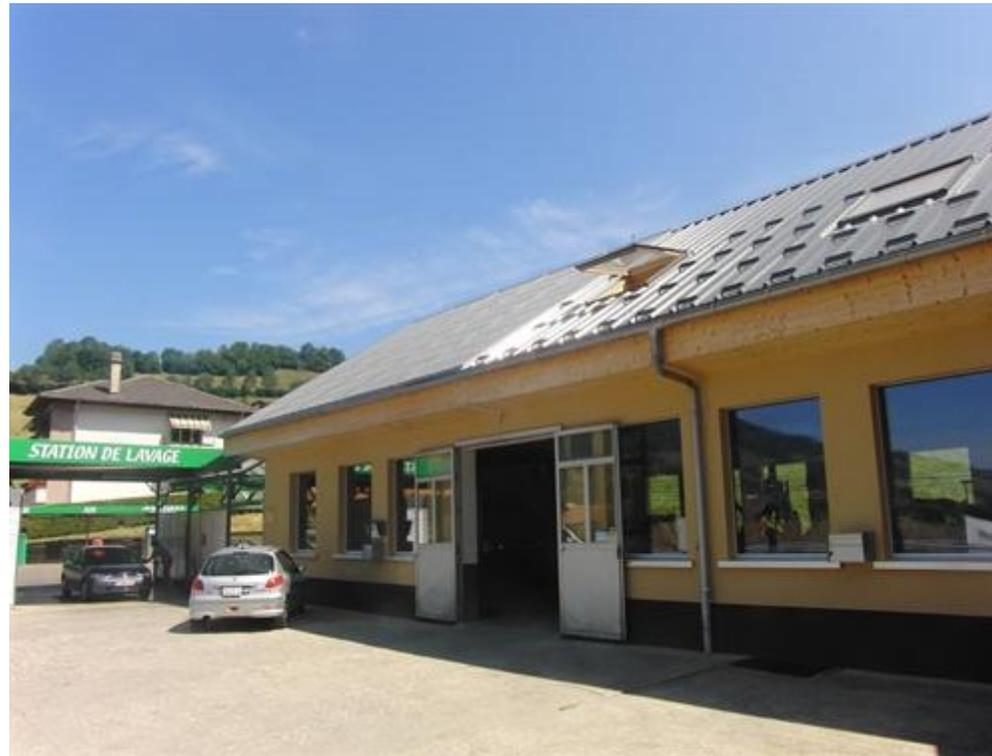
Beaud Bernard, Charmey. Rénovation. 67.5 m<sup>2</sup> en autoconstruction pour un garage, 2 tunnels de lavage, un salon de coiffure, un économat, un appartement de fonction, une rampe à maintenir hors-gel. Gain direct et indirect du au solaire de 4'500L de mazout sur 8'000. Elimination d'une chaudière à mazout, de 2 boilers électriques, d'un contrat d'entretien, de 3 ramonages par année. Coût négatif sur 20 ans avant même d'avoir tiré le premier kWh.
