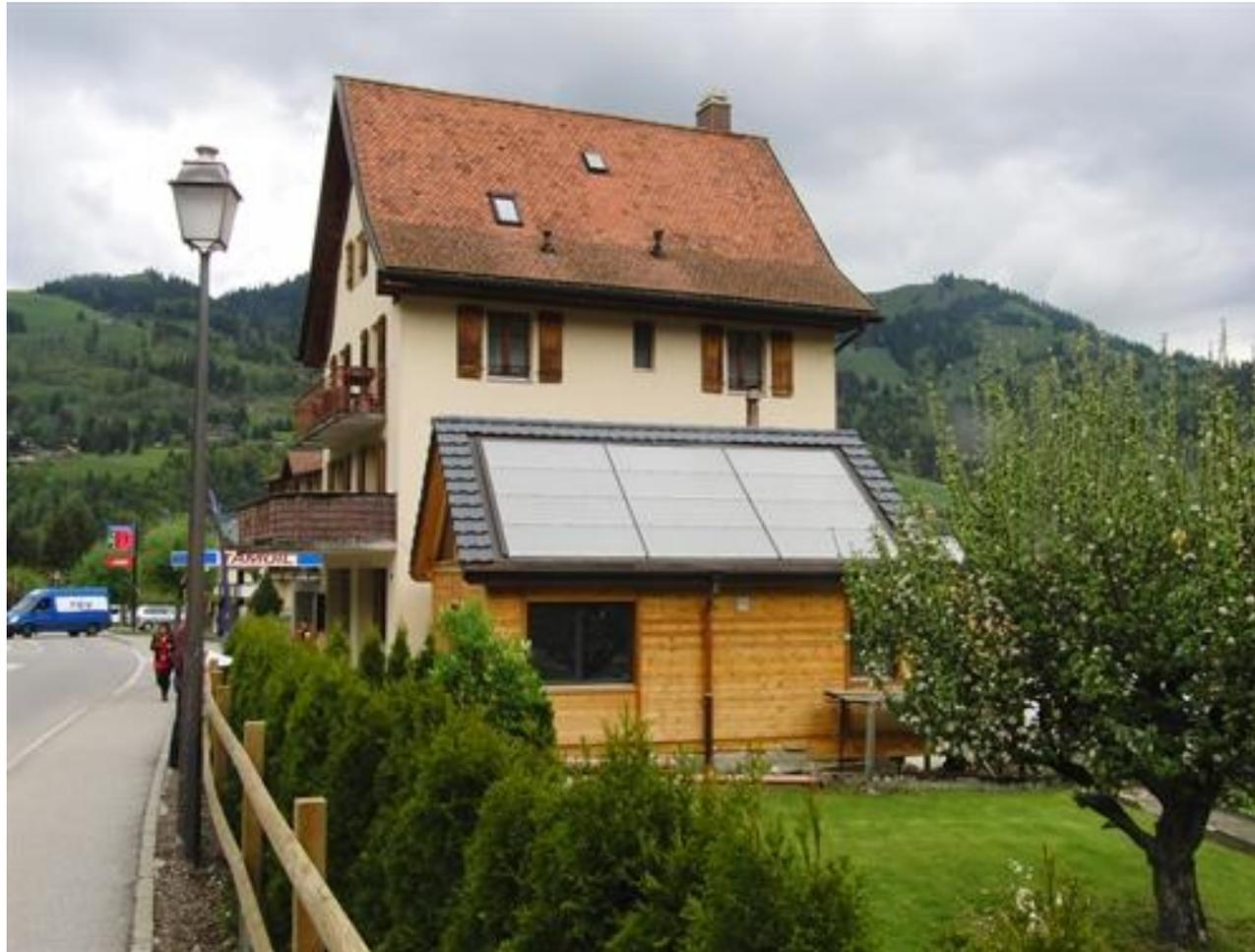
Beaud Dominique, Charmey. Rénovation. 18 m<sup>2</sup> en autoconstruction pour trois appartements sur 2 immeubles, un atelier de vente de vélos, poêle hydro, distributions HT, BT et TBT, système de facturation de la chaleur solaire et bois fournie dans miniréseau entre les 2 immeubles.
