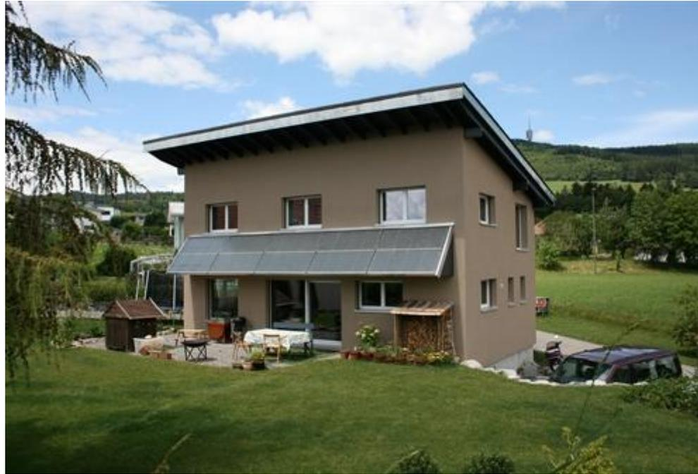
Jaquier, Sorens. Minergie-P à neuf. 180m<sup>2</sup> chauffés. Famille de 4 personnes. 15m<sup>2</sup> solaire, poêle hydro, distribution, ventilation en autoconstruction. Couverture solaire > 80%. Bois < 1 stère/an
